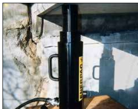
◀ El cilindro portátil con contratuerca RACL1506 utilizado para soporte de carga durante largo tiempo durante inyección de epoxi para refuerzo de puente.
